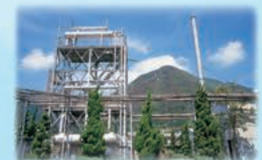
本社工場 Head office factory
